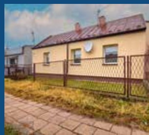
Częstochowa - ul. Bat. Chłopskich - dom o pow. ok 80m 2 na działce 619m 2 , nowoczesna kotłownia
